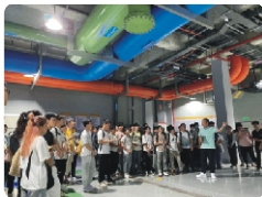
学生在制冷机房认识实习
