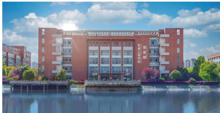
机械工程学院大楼
